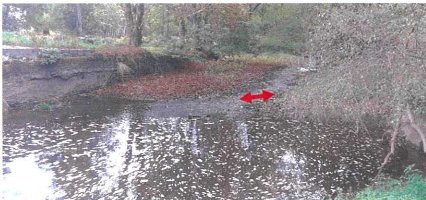
Vue amont de la retenue comblée
