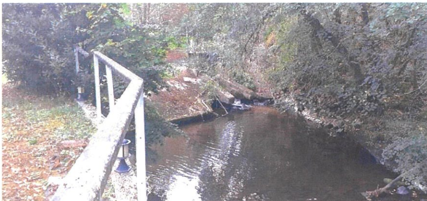
Vue aval seuil du Moulin de Rouchillou
